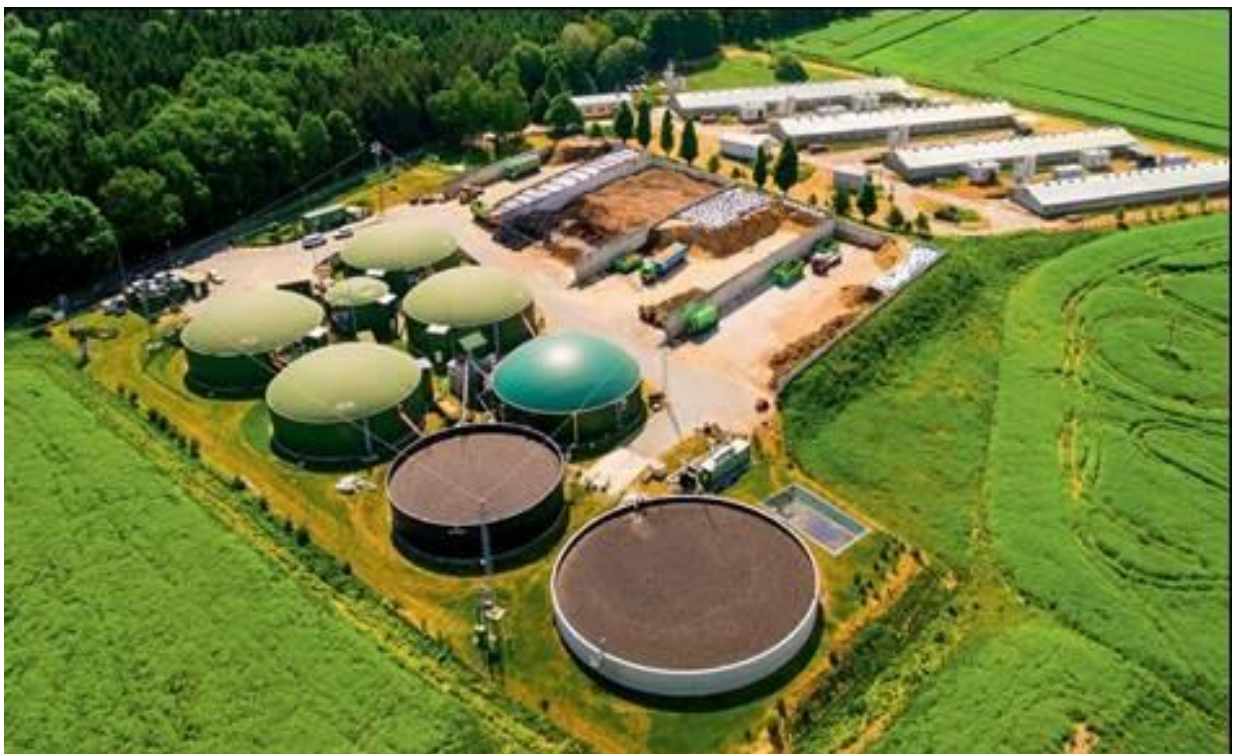
Рис. 12.7. Єдиний виробничий комплекс тваринницької ферми і заводу з виробництва біогазу та дигестату – біоконверсії органічних відходів тварин
